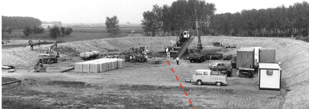
Sermide 1982 – Crossing of Po River Allacciamento Centrale Enel DN 500 (20")
