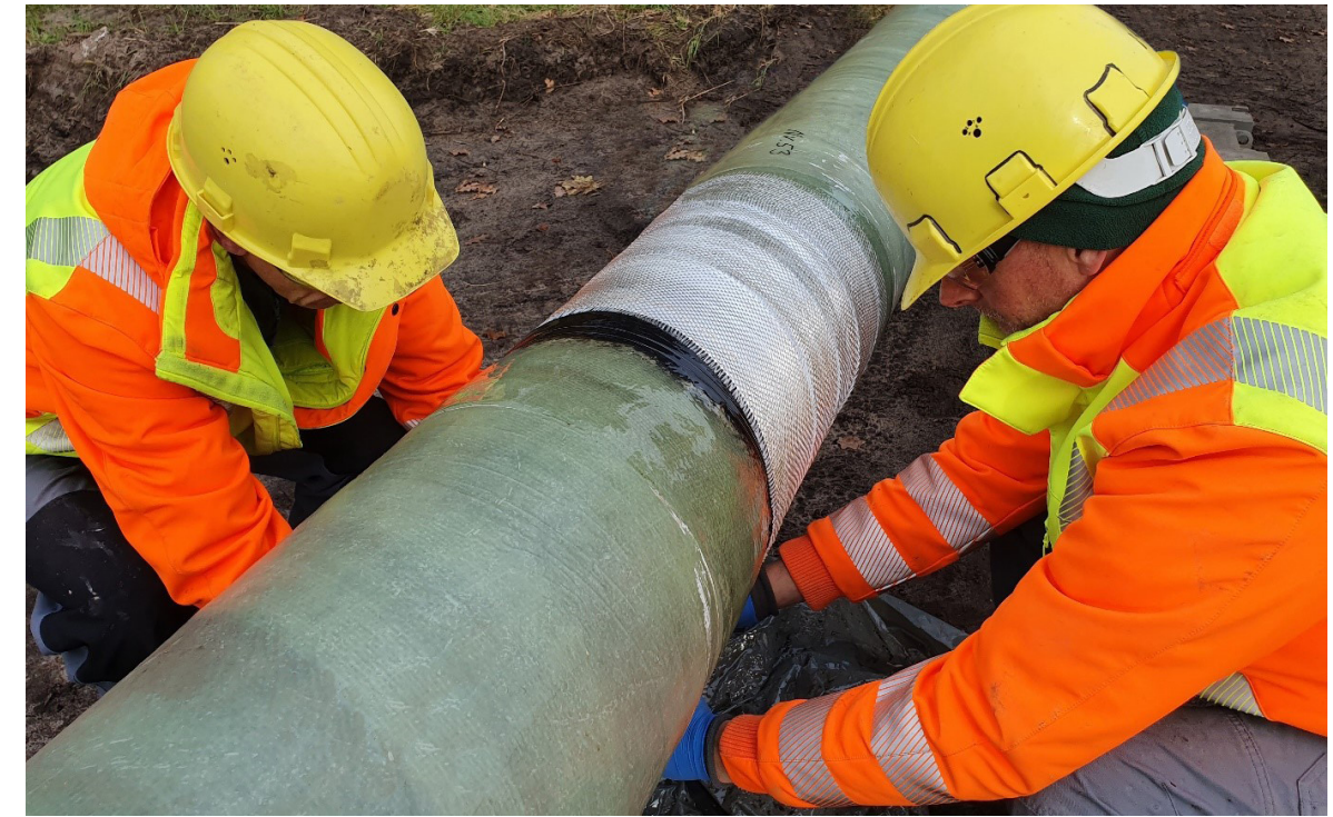
Abbildung 11: Zusätzliche Beschichtung der Schweißnaht mit glasfaserverstärktem Kunststoff
