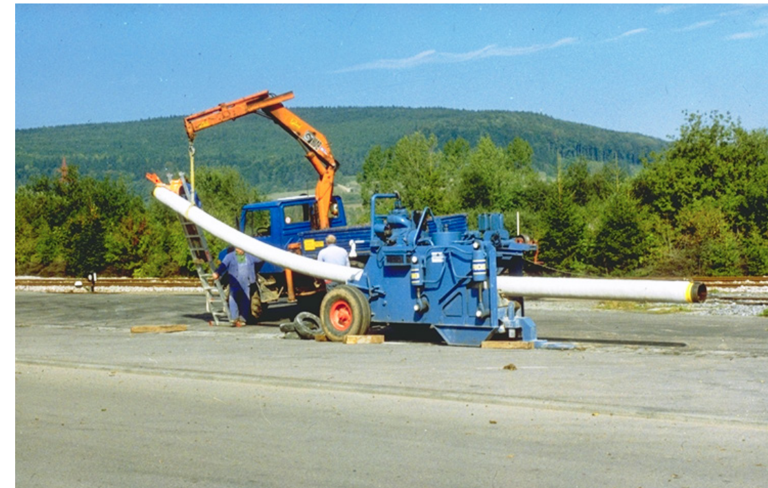
Abbildung 6: Biegen von FZM-ummantelten Rohren
