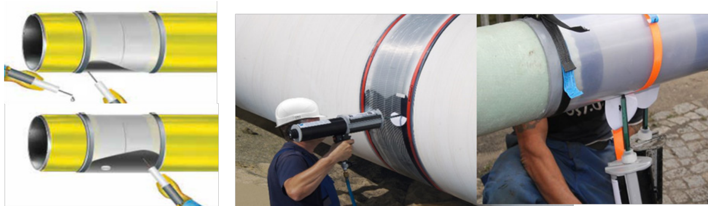
Abbildung 10: Einspritzen des Polyurethans in das Gehäuseblech mit der speziellen Zweikammerkartusche
