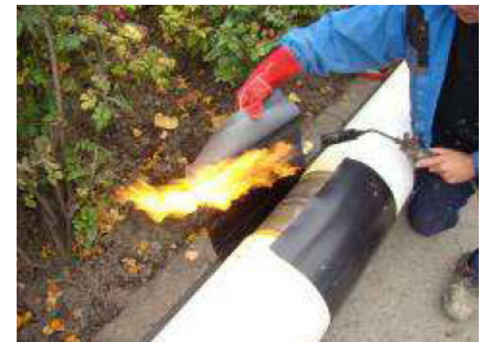
Abbildung 13: Aufbau „DIRAX-System“
