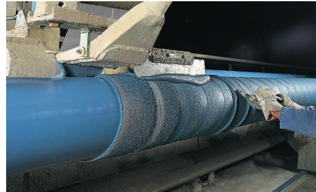
Abbildung 5: Herstellung der FZM-Ummantelung
