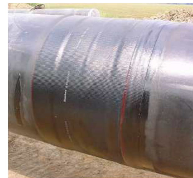
Abbildung 12: Schweißnahtnachumhüllung „DIRAX-System“
