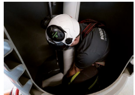
Das Kerngeschäft der Bodenbender Group liegt in der grabenlosen Kanalsanierung. | Foto: Bodenbender (Symbolbild)
