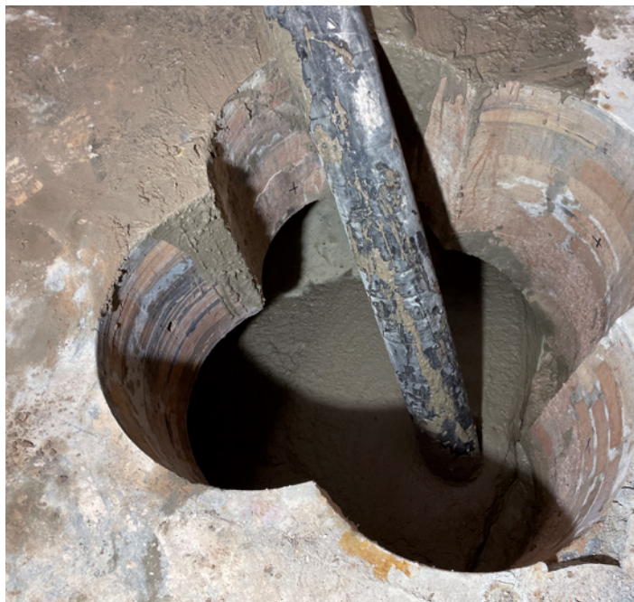
Über einen langen Schlauch wird der Flüssigboden in die zu verfüllende Ebene gepumpt.
