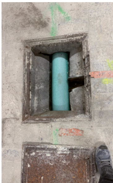
Der Brawoliner 3D eignete sich insbesondere für die vorhandenen Rohrverhältnisse.
