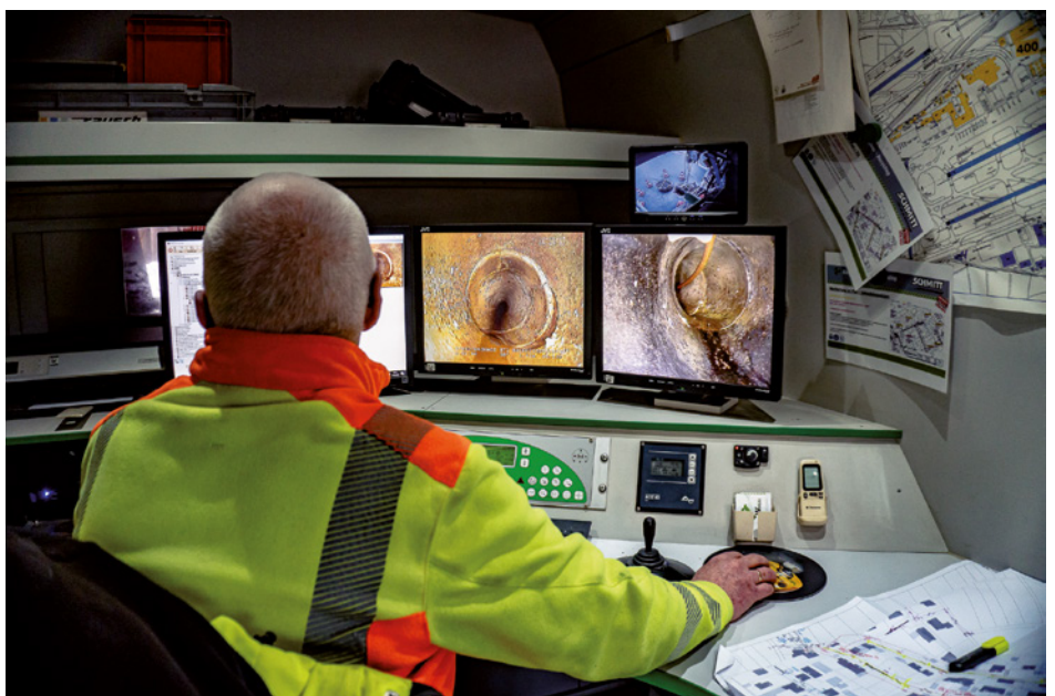
Mittels moderner TV-Inspektion werden Schäden wie Risse oder Korrosion aus dem Einsatzfahrzeug heraus präzise lokalisiert.
