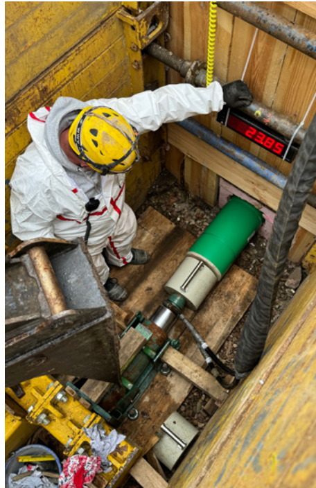
Das Berstverfahren ersetzt das Altrrohr in gleicher Trasse. Die neuen Kurzrohre aus PP-HM DN 250 zeichnen sich durch hohe Ringsteifigkeit und chemische Beständigkeit aus. | Fotos: Sanierungstechnik Dommel
