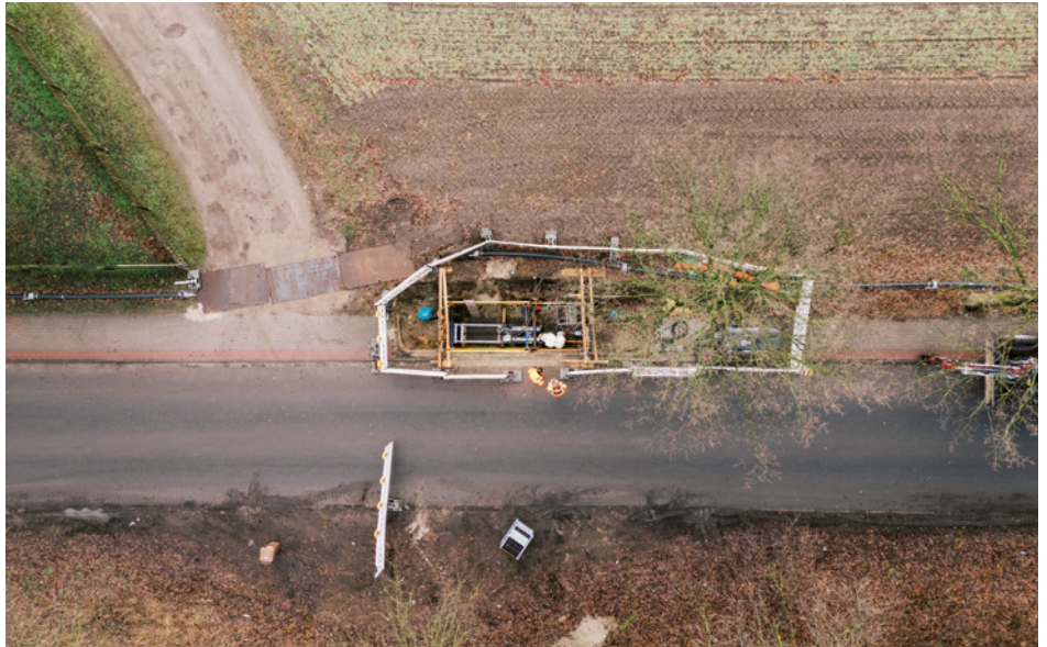
Nur punktuelle Baugruben sind erforderlich. Über diese wird das Berstgestänge eingezogen und das neue Rohr in gleicher Trasse verlegt. | Foto: Tracto
