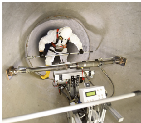
Standfestigkeit: MAC-Verfahren prüft das gesamte Boden-Rohr-System
