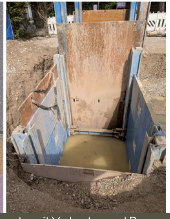
Herstellung der Baugrube mit Verbaubox und Bagger
