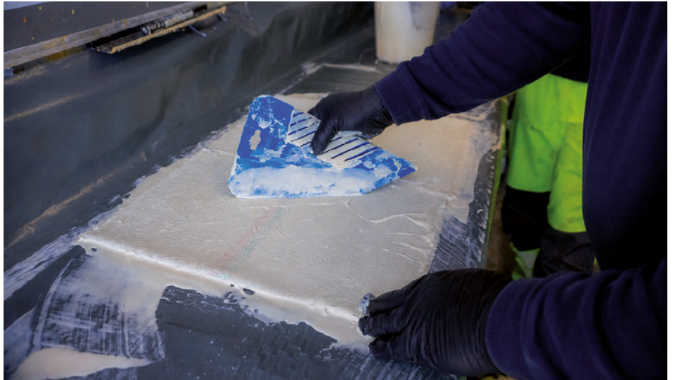
Handwerk trifft Hightech: Für die grabenlose Sanierung wird ein spezieller Liner präzise für den Einbau vorbereitet.
