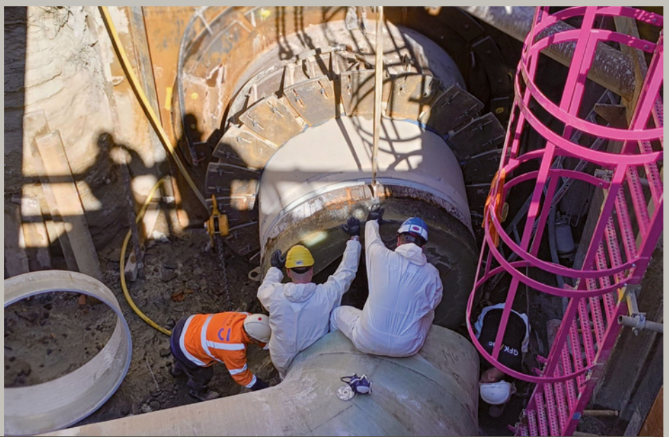
Baustelle Hamburg-Fuhlsbüttel: Als Verbindung zwischen Vortriebsrohr (Polymerbeton) mit PEHD-Auskleidung und GFK-Rohr wurde eine Stahlmanschette mit GFK-Platten eingebaut. | Foto: B_I/Valdix
