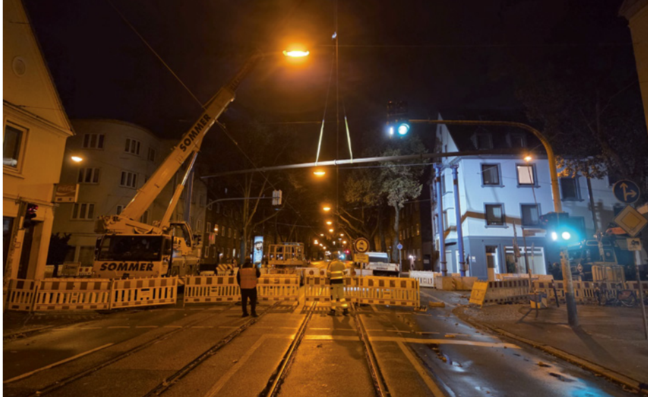
Installation der Vorflutsicherung: Die aufgeständerte Bypassleitung wurde nachts verlegt, um den kontinuierlichen Abwasserabfluss während der Sanierungsarbeiten bei laufendem Straßen- und Straßenbahnverkehr sicherzustellen. | Fotos: Swietelsky-Faber
