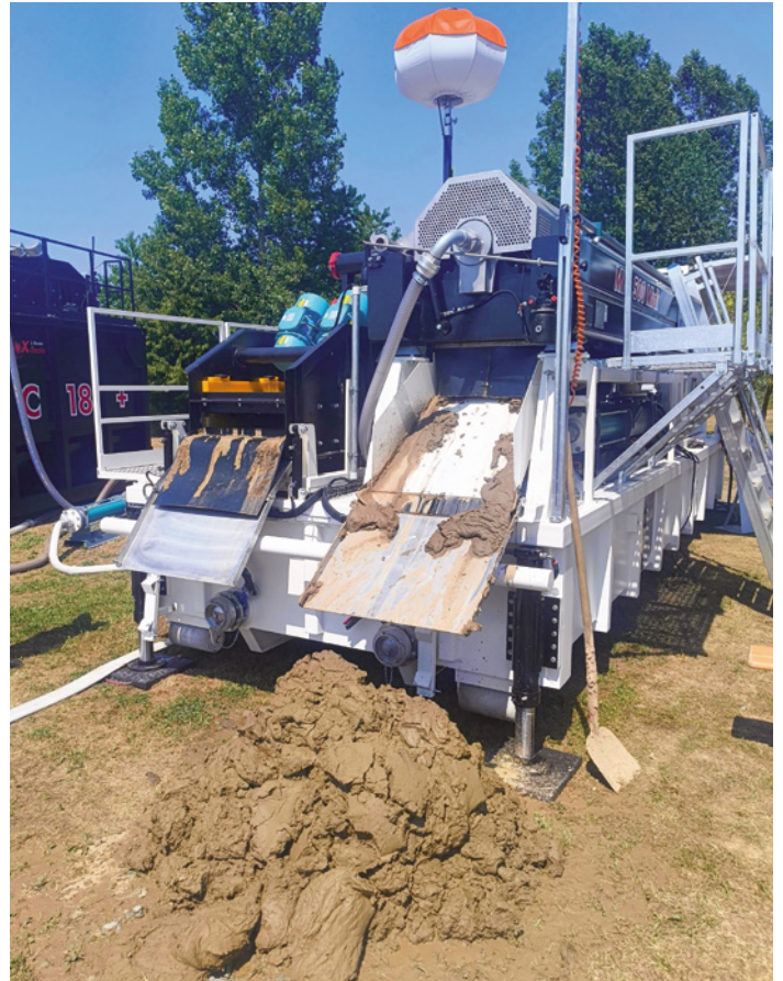
Mit dem MRS 500 Midi wurde die Separation und Aufbereitung von Bohrspülung durchgeführt.
