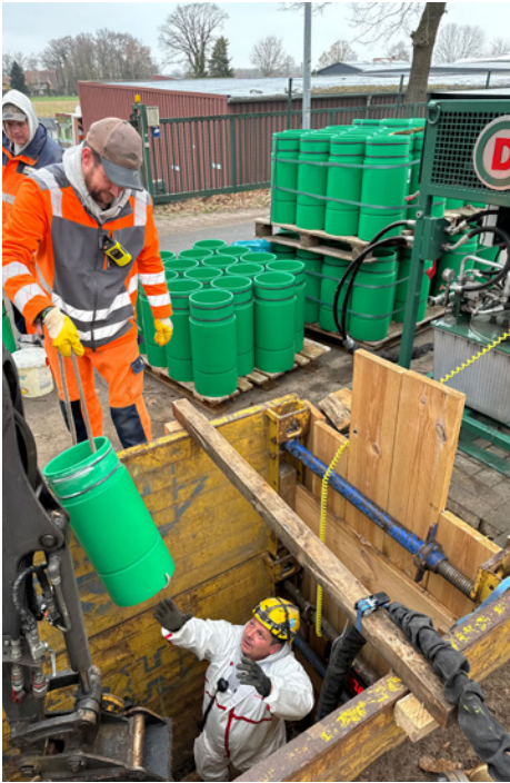
Das Berstverfahren ersetzt das Altrrohr in gleicher Trasse. Die neuen Kurzrohre aus PP-HM DN 250 zeichnen sich durch hohe Ringsteifigkeit und chemische Beständigkeit aus. | Fotos: Sanierungstechnik Dommel
