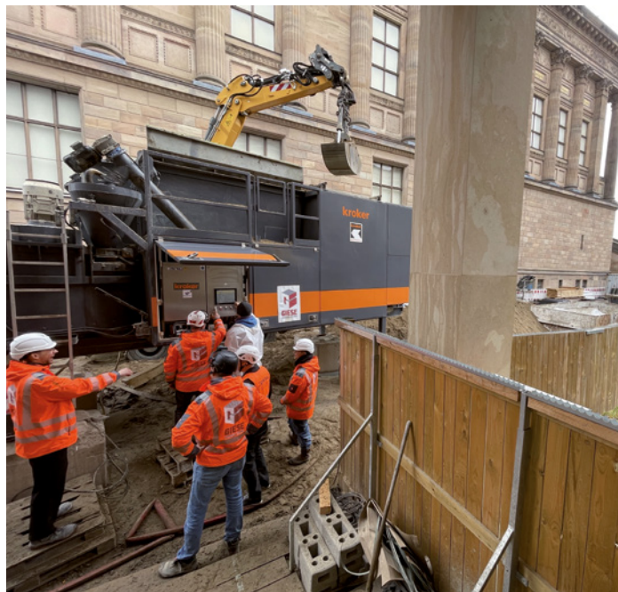
Aufbereitet wurde der Flüssigboden mit einer mobilen Mischanlage (CM30+).
