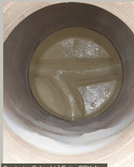
Sanierter Schacht | Foto: GFK/tec
