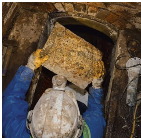
Entnahme einer Materialprobe nach 40 Jahren Betriebszeit zur Feststellung der Materialeigenschaften | Foto: Aarsleff Rohrsanierung GmbH
