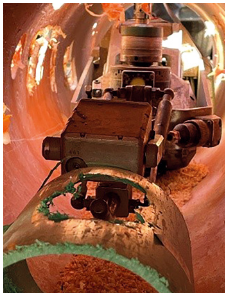
Eigene Aufnahmen Pipetronics – Multi-Roboteranlage
