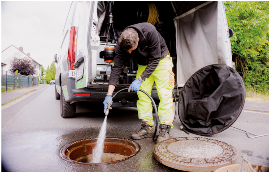
Reinigung des Schachts für die Schachtinspektion.
