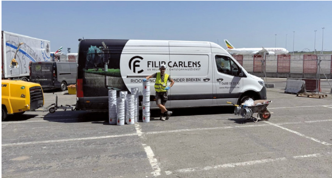
Grabenlose Sanierung umgeben von Flugzeugen am Airport Brüssel: Hier wurden 500 m Tonrohre mit Brawo-liner 3D erfolgreich saniert. | Fotos: Brawo Systems
