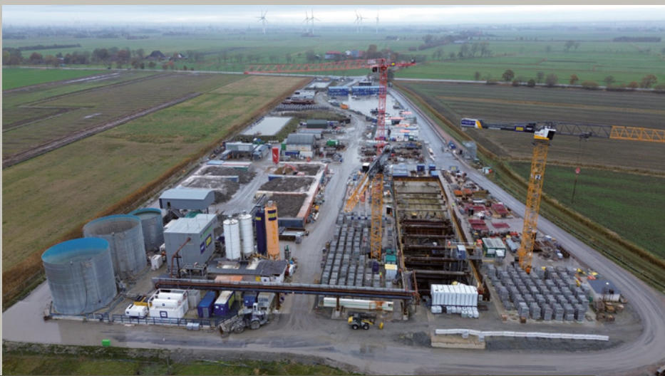
SuedLink wird Windstrom vom Norden in den Süden Deutschlands transportieren.
