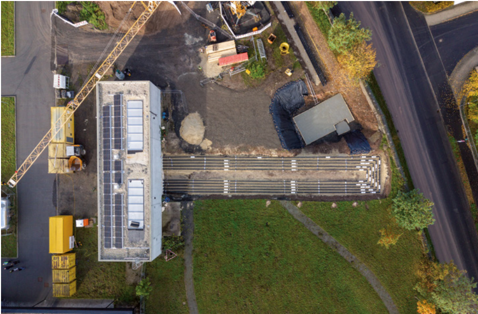
Teststrecke für das zukunftsweisende Forschungsprojekt «EnEff:Wärme: UrbanTurn - Wandelung der urbanen leitungsgebundenen Wärmeversorgung» | Fotos: Brugg
