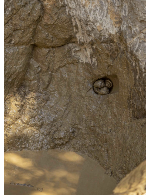
Erfolgreiche Pilotbohrung im Wirelineverfahren
