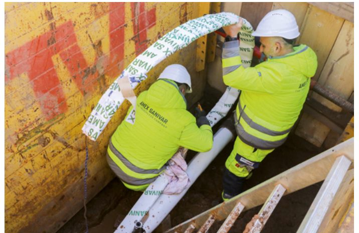
Einzug des SaniTube-Liners in die bestehende Trinkwasserleitung | Fotos: Amex Sanivar
