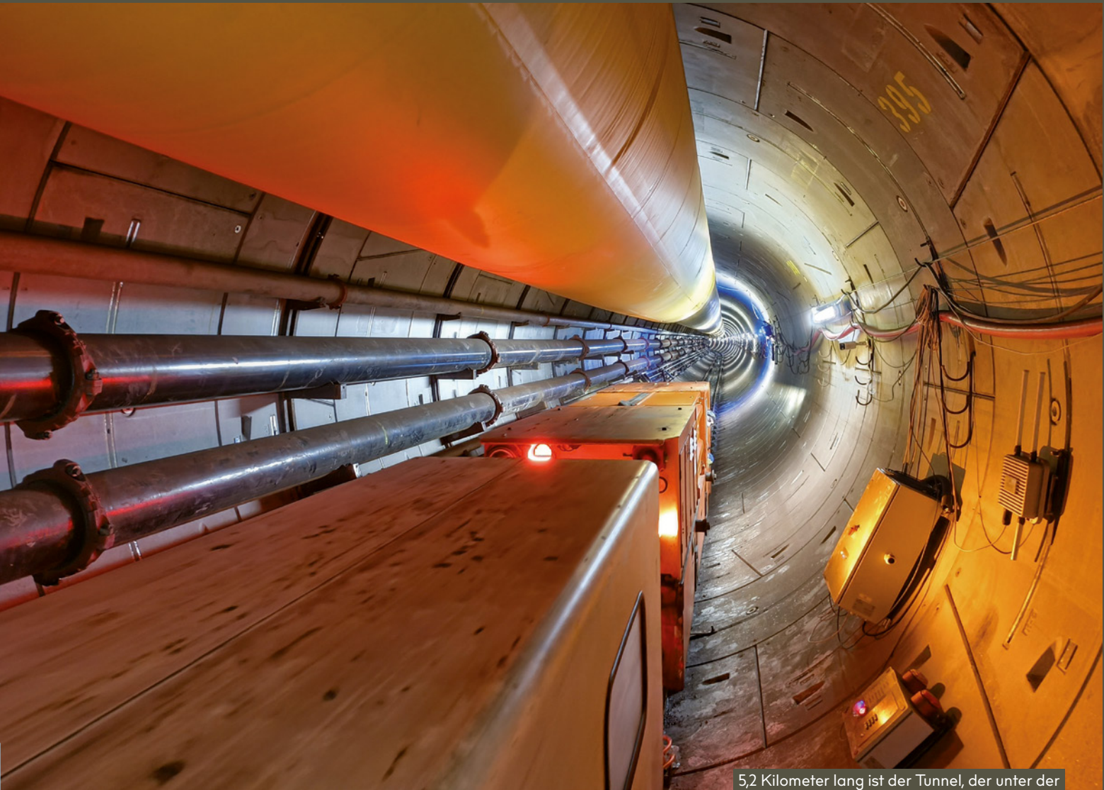
ElbX-Tunnel für SuedLink
