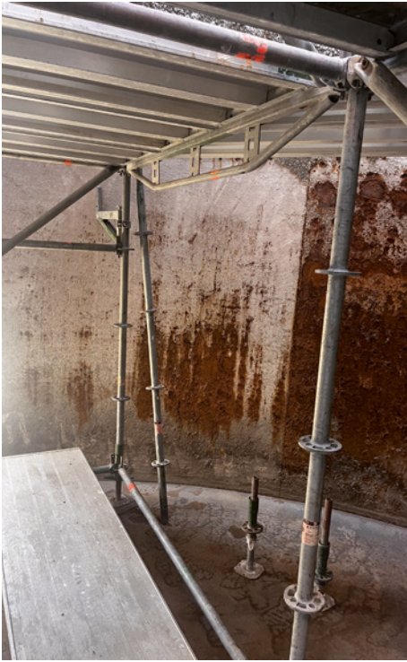
Behälterwand vor der Sanierung | Fotos: Swietelsky-Faber
