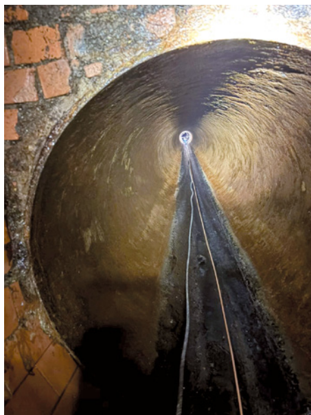
Manuelles hydromechanisches Entfernen der auf der Korrosionsschutzschicht anhaftenden Ablagerungen – Zustand der DN1000-Leitung nach der Reinigung und Vorbereitung für den Linereinbau
