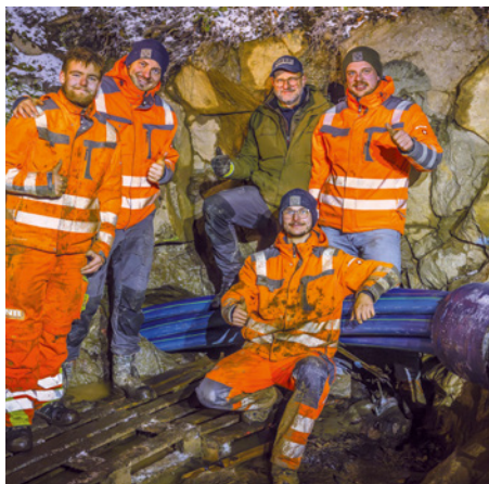
Erfolgreicher Rohreinzug von sieben PEHD-Rohren mit einer Länge von jeweils 420 m
