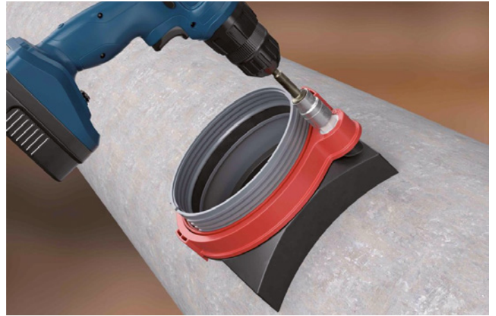
Montage mit dem Akku-Bohrschrauber: Der VPS Turbo von Funke ist für nachträgliche Einbindungen in Kanalrohre mit Nennweiten von DN 300 bis DN 2400 ausgelegt. | Foto: Funke Kunststoffe
