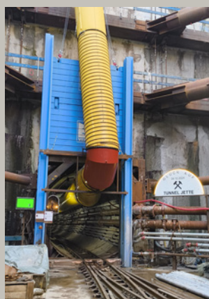
Rauch- und Hochwasserschotts gehören zu den bauzeitlichen Sicherheitsmaßnahmen beim Projekt ElbX. | Foto: B_I/Valdix
