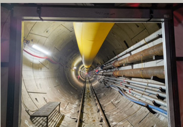
Rauch- und Hochwasserschotts gehören zu den bauzeitlichen Sicherheitsmaßnahmen beim Projekt ElbX. | Foto: B_I/Valdix
