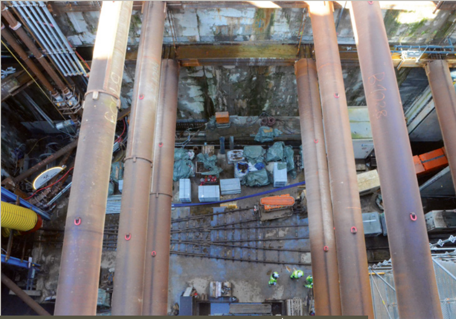
25 m tief und 60 m breit sind die Start- und Zielbaugrube. | Foto: B_I/Saric
