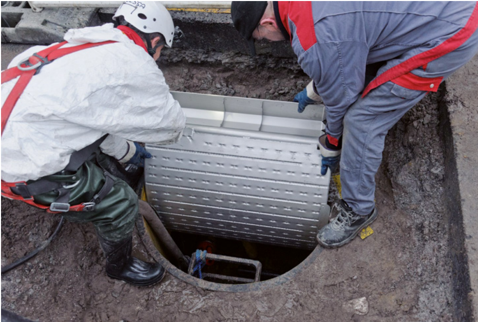
Einbringen der Wärmeübertragerelemente in den Kanal
