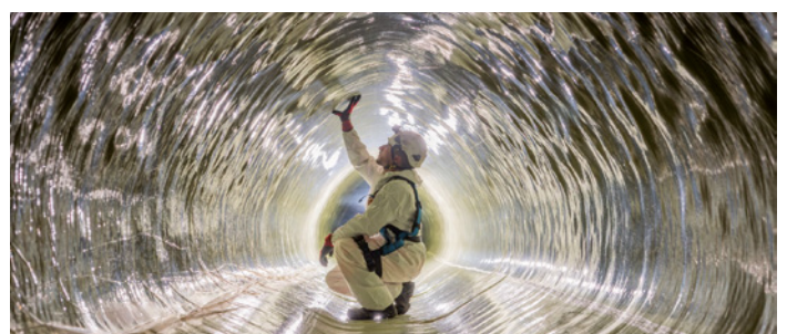
Eingebauter BB Flex in Rotterdam | Foto: Brandenburger Liner
