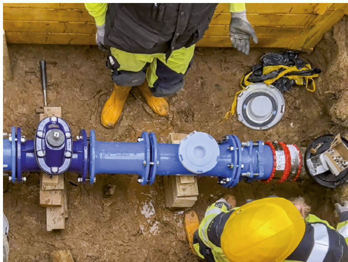
Einbau und Anschluss einer sanierten Trinkwasserleitung im Rohrgraben
