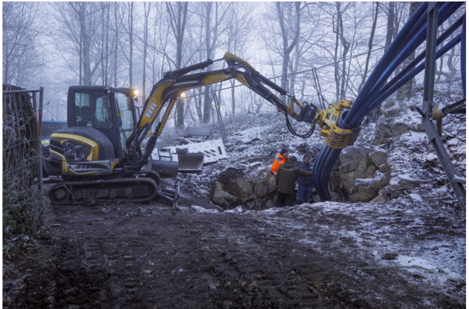
Vorbereitungen zum Rohreinzug auf dem Gipfel der Milseburg
