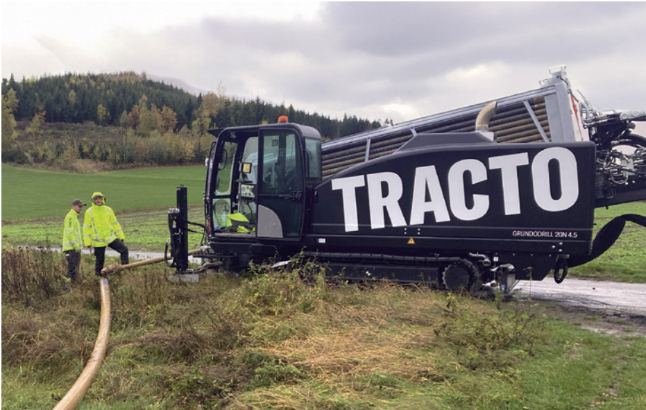
Der Grundodrill 20N wurde mit unterschiedlichen Gestängelängen realisiert. Modell 4.5 hat 70 Gestänge à jeweils 4,5 m an Bord, um auch lange Bohrungen zügig an einem Stück durchzuführen. | Fotos: Tracto-Technik
