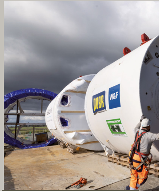
Die Tunnelbohrmaschine vom Typ Mixschild (Slurry-TBM) verfügt über ein Schneidrad mit einem Durchmesser von 4,94 m. | Foto: Porr
