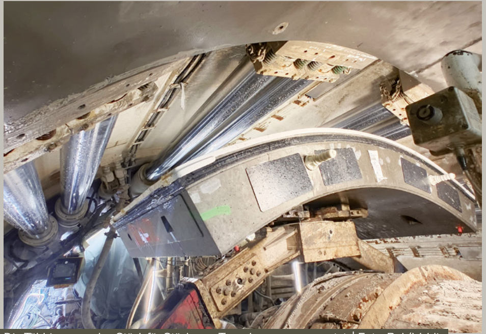
Die Tübbinge werden Stück für Stück zum Tunnel zusammengesetzt. | Foto: B_I/Valdix
