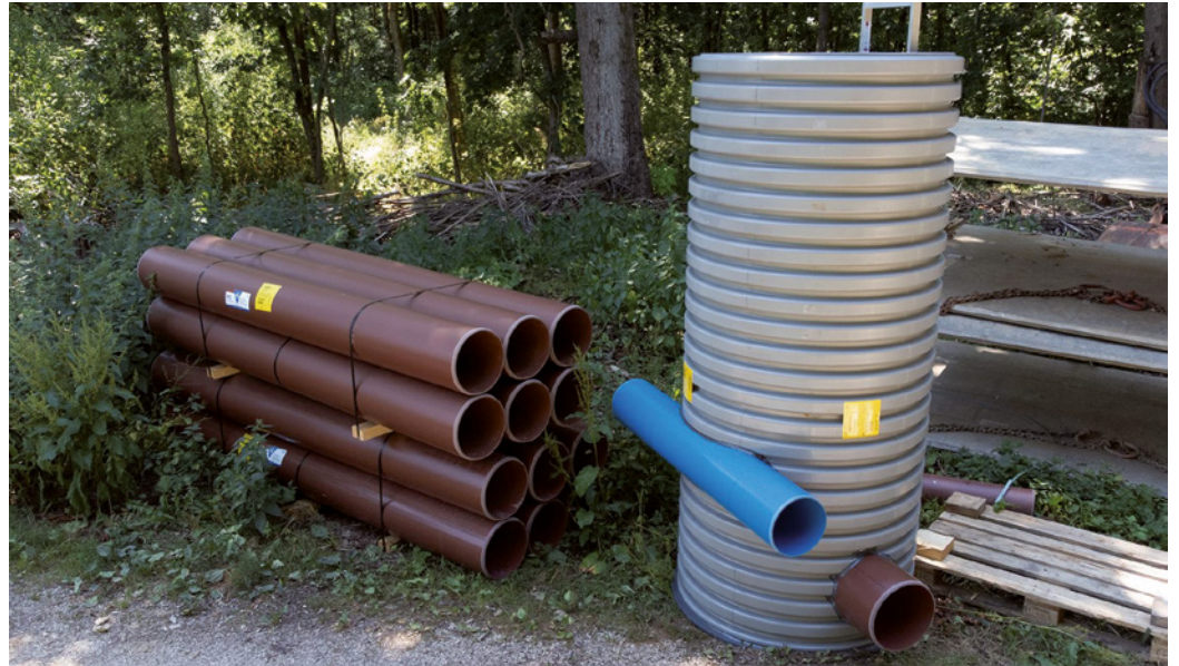
Bereit für den Einbau: HS-Kanalrohre und ein DWCOr-Kombischacht
