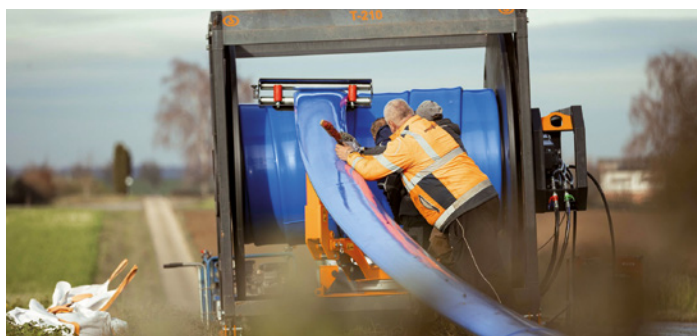
Die neu entwickelte Trommleinheit ermöglicht den wiederholten Einsatz des Liners bei Bypass- und Notfallanwendungen. | Foto: Rädlinger Primus Line
