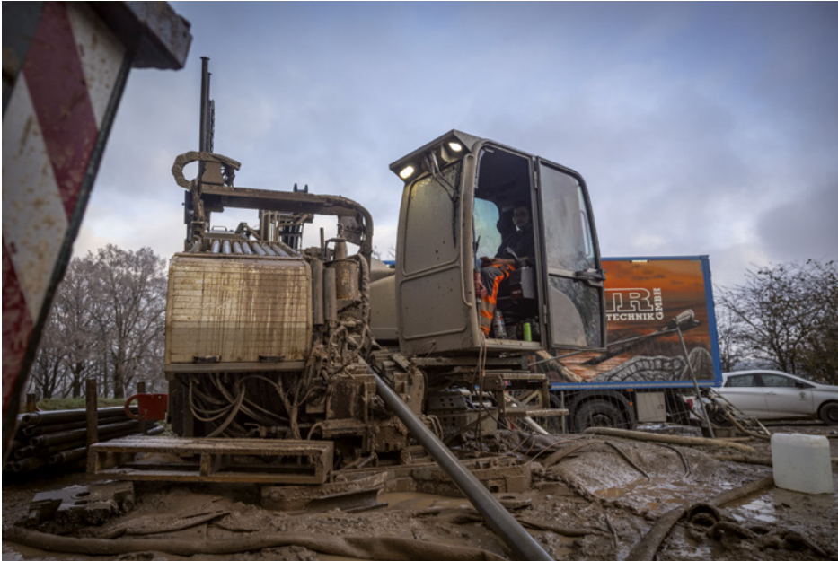
Bohranlage Grundodrill 28N von Tracto im Einsatz
