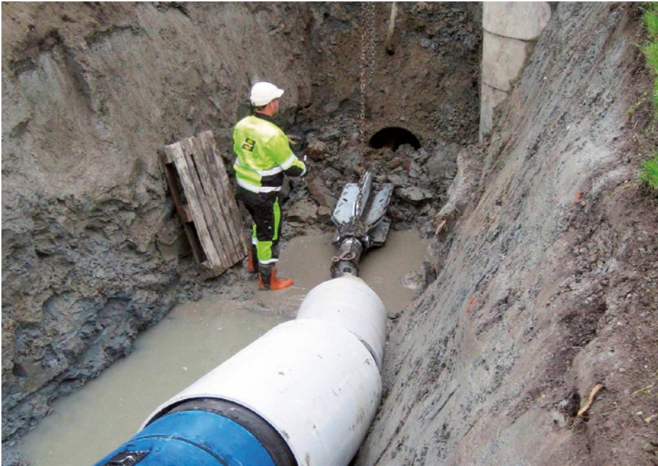
Im grabenlosen Berst-Verfahren könne auch große Durchmesser erneuert werden. | Fotos: Tracto
