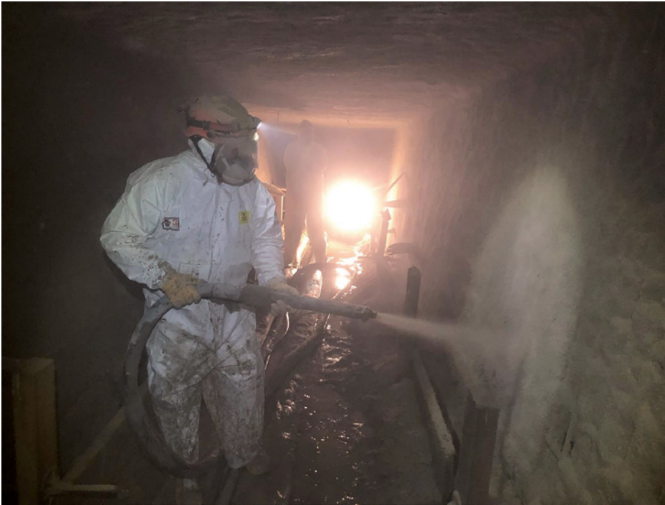
Spritzbetonarbeiten im verrohrten Abschnitt des Röthenbachs | Foto: Swietelsky-Faber GmbH
