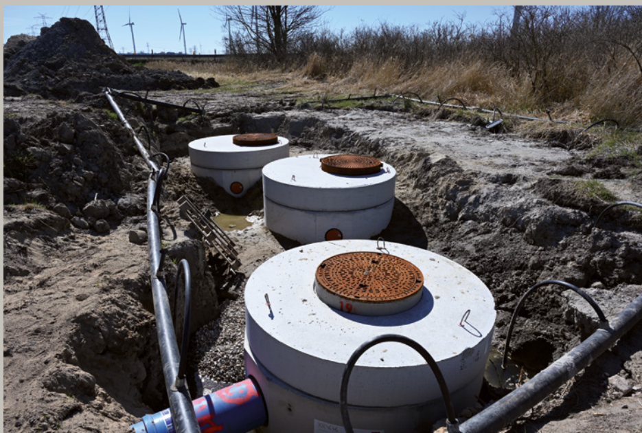
Aco Stormclean: Regenwasserbehandlungsanlage mit DIBt-Zulassung in kompakter Bauweise
