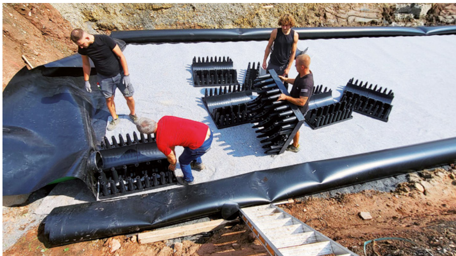
Der Regenwasserspeicher am Rande eines Wohngebietes entsteht. In der untersten Ebene werden die Grundelemente mit Sedimentationskanal eingebaut. | Fotos: Birco
