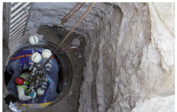
Jumbo-Kern in der Baugrube
