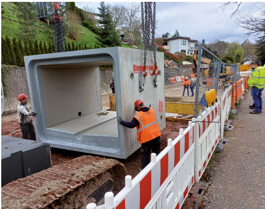
Dank einer guten Planung verlief die Montage der Elemente reibungslos. | Foto: Peter Gross Infrastruktur GmbH & Co. KG
