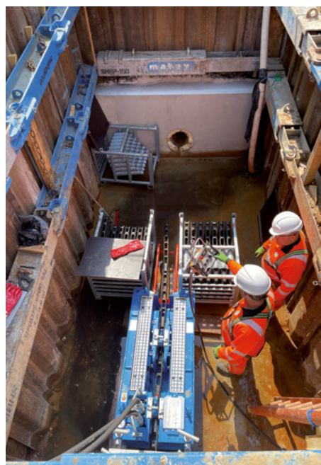
Platzsparend: Das Grundoburst-System erneuert Rohre aus einer kompakten Grube
