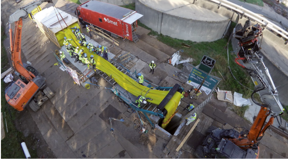
In Brugge wurde ein Impreg-Liner DN 2000 eingebaut. | Fotos: Impreg
