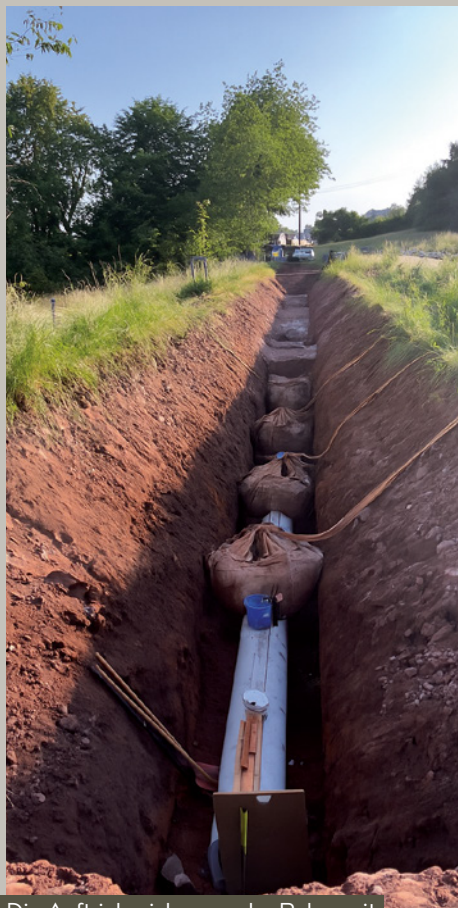
Die Auftriebssicherung der Rohre mit Big Bags. | Foto: OBG
