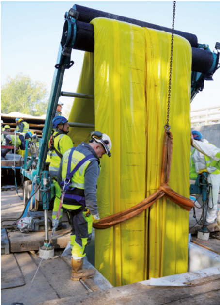
Einzug des Impreg-Liners in den Schacht
