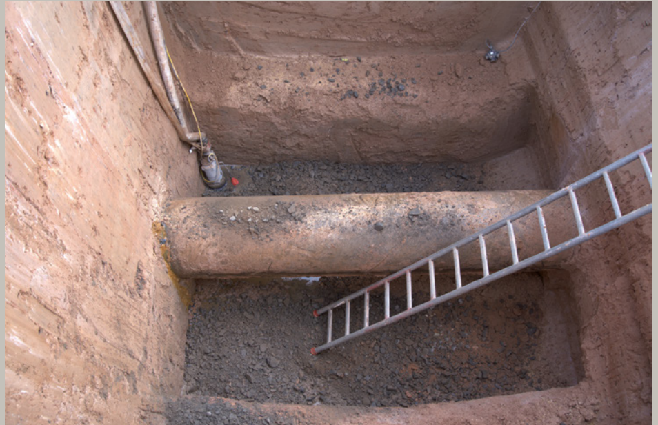
Schutzrohr in Zwischengrube vor Zweitverfüllung und nach Abschluss der Arbeiten
