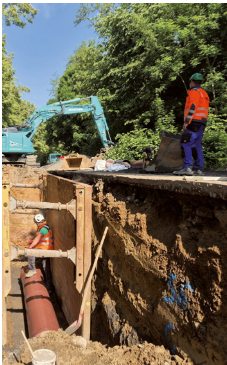
Die Kanalrohre in der Liebigstraße werden in einem gemischtkörnigem Fels-Lehm-Gemisch der Bodenklasse 6 und in Tiefen zwischen 2,00 und 2,50 m verlegt.
