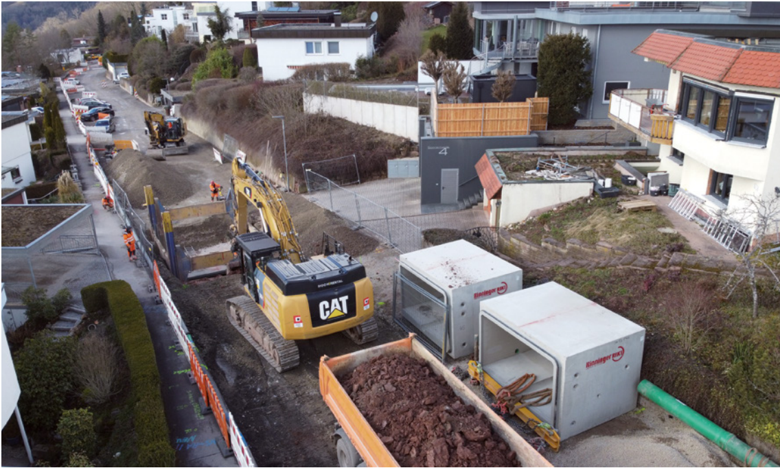
Im Zuge der Reaktivierung der Hermann-Hesse-Bahn (HHB) und zweier S-Bahnlinien wurde in der Sonnenhalde in Calw-Heumaden die Entwässerung neu angelegt. | Foto: Hans Rinninger u. Sohn GmbH u. Co. KG
