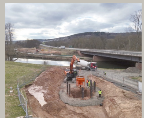
Damit sich der Flüssigboden beim Einbringen in die tiefe Grube nicht durch zu hohen Energieeintrag entmischt, wurde er mit Kübeln und somit geringerer Fallhöhe eingebracht.
