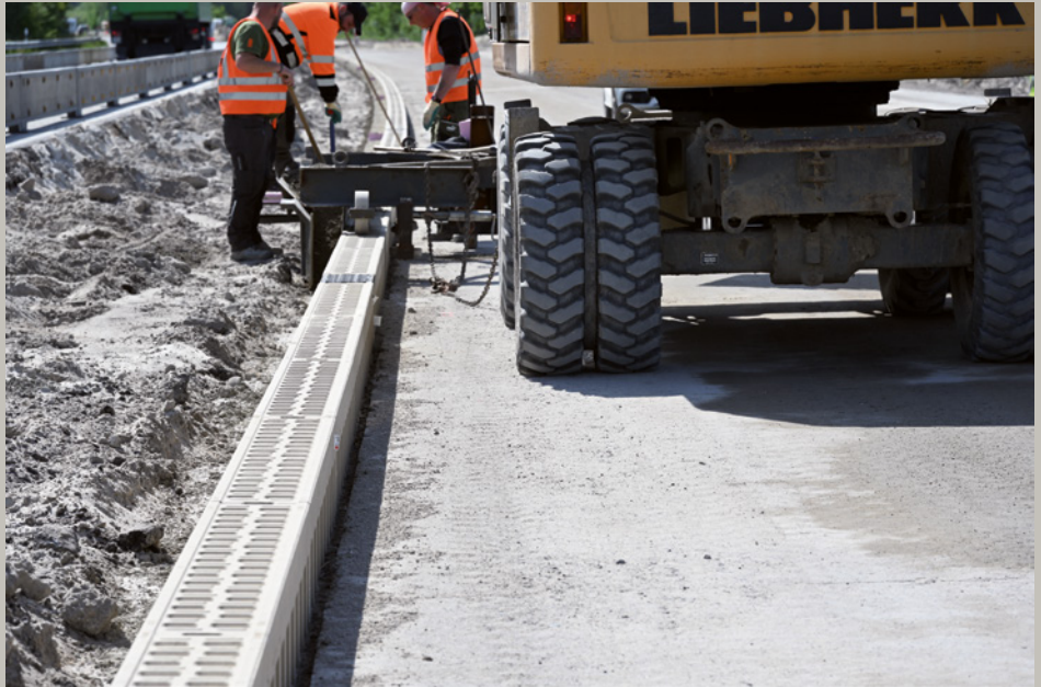
Einbau der Drain Monoblock RD 200 im Mittelstreifen
