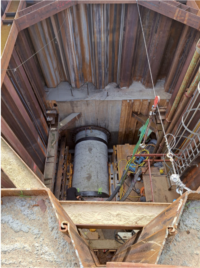
Startbaugrube mit Vortriebsrohr
