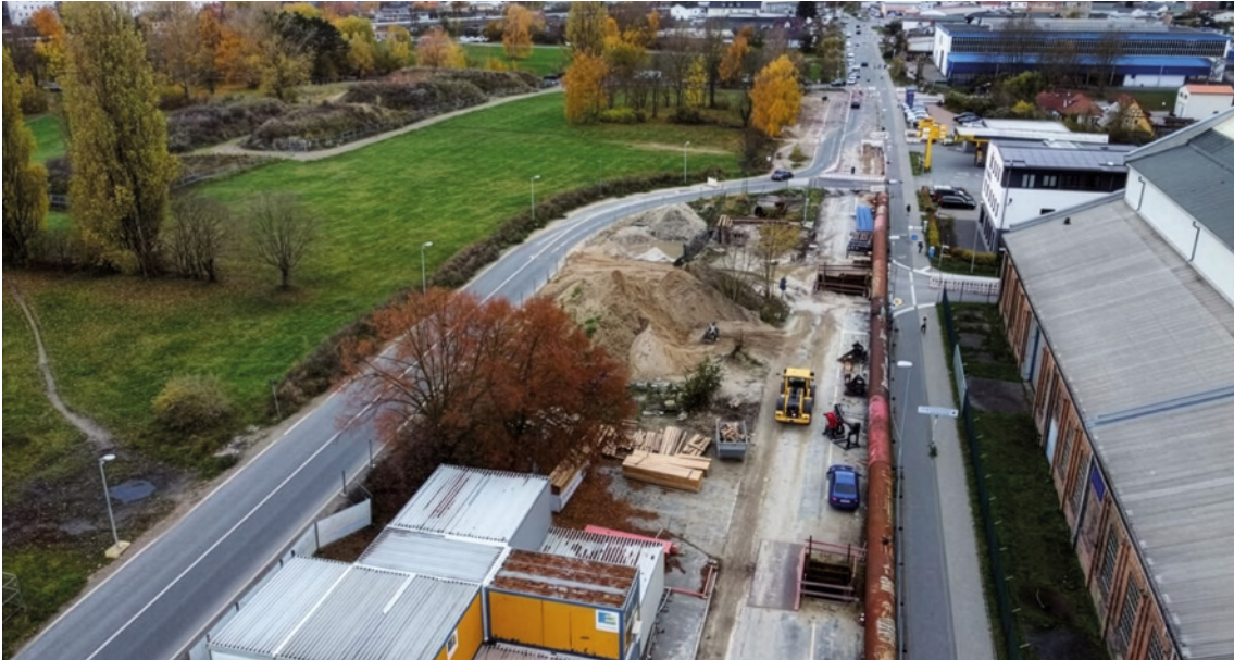
Anteiliges Baufeld mit Baugruben, Heber, Ersatzstraße, BE-Fläche | Fotos: Echterhoff
