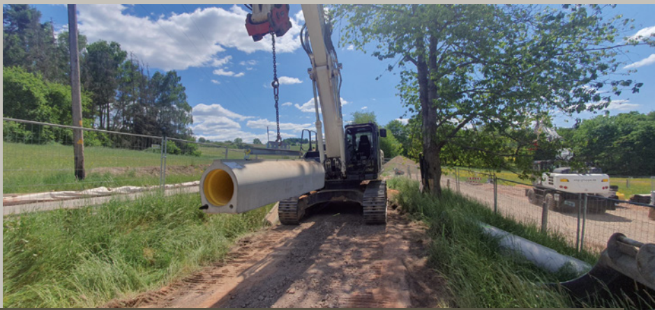
Einfaches Handling der Rohre durch die Verlegeanker oben im Rohrscheitel. | Foto: OBG
