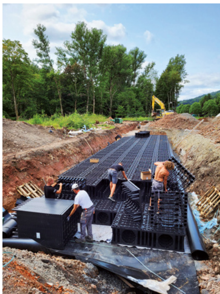
Lage für Lage entsteht ein enormer Regenwasserspeicher im Untergrund – zum Schutz der Wohnsiedlung bei Starkregenereignissen bzw. kontrollierten Einleitung des gereinigten Wassers in das Grundwasser.
