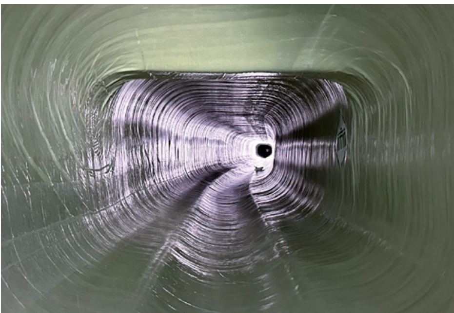
Abbildung 1: Mit gewickeltem Schlauchliner sanierte Haltung mit Querung | Foto: Brandenburger Liner
