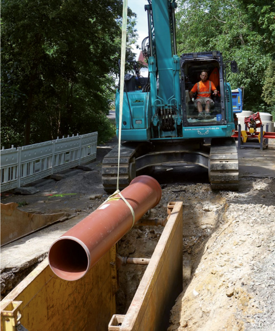
In der Liebigstraße kommen HS-Kanalrohre SNI6 in Nennweiten von DN/OD 315 bis DN/OD 500 für den Mischwassersammler zum Einsatz. | Fotos: Reuscher Tiefbau GmbH
