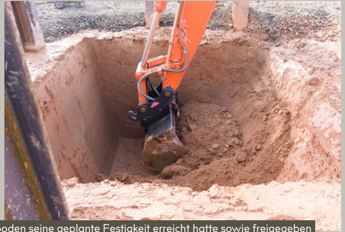
Freilegen der Wände nach der Durchörterung und nachdem der Flüssigboden seine geplante Festigkeit erreicht hatte sowie freigegeben wurde
