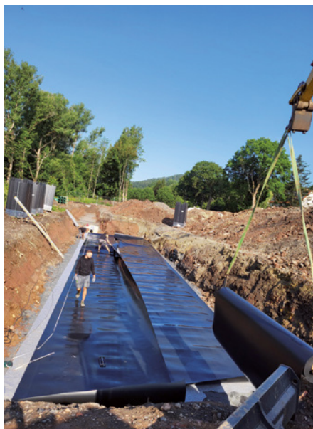
Das Planum ist angelegt. GeoVlies und Folienbahnen werden vor dem Aufbau von den Birco Rainblock Rigolenfüllkörpern ausgelegt.
