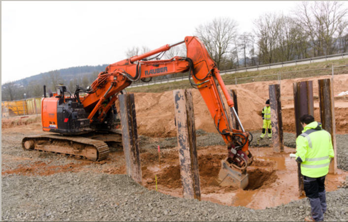
Freilegen der Wände nach der Durchörterung und nachdem der Flüssigboden seine geplante Festigkeit erreicht hatte sowie freigegeben wurde
