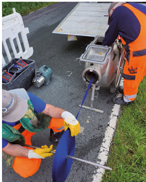
Vorbereitung der Inversionstrommel | Foto: Rainer Kiel Kanalsanierung
