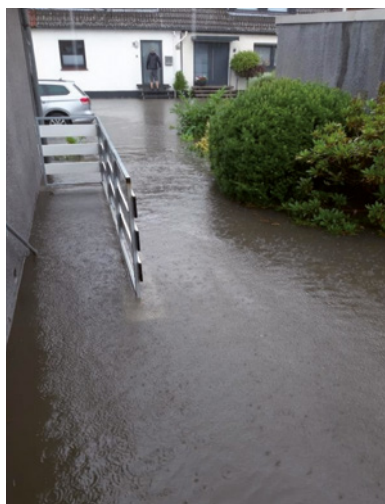
Rechts: Überfluteter Kellernieder-gang
