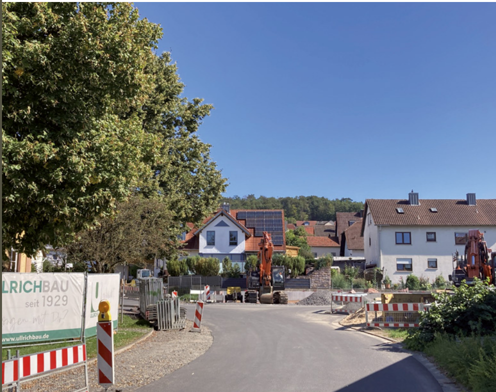
Gemeinde Fuchsstadt im Landkreis Bad Kissingen, Straßensanierung „Am Kohlenberg“ | Fotos: Aco
