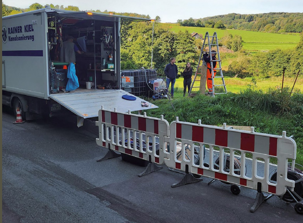
Die Sanierung des Hinterlandkanals in Kiesbert stellte die Baupartner vor vielfältige Herausforderungen. | Foto: Rainer Kiel Kanalsanierung
