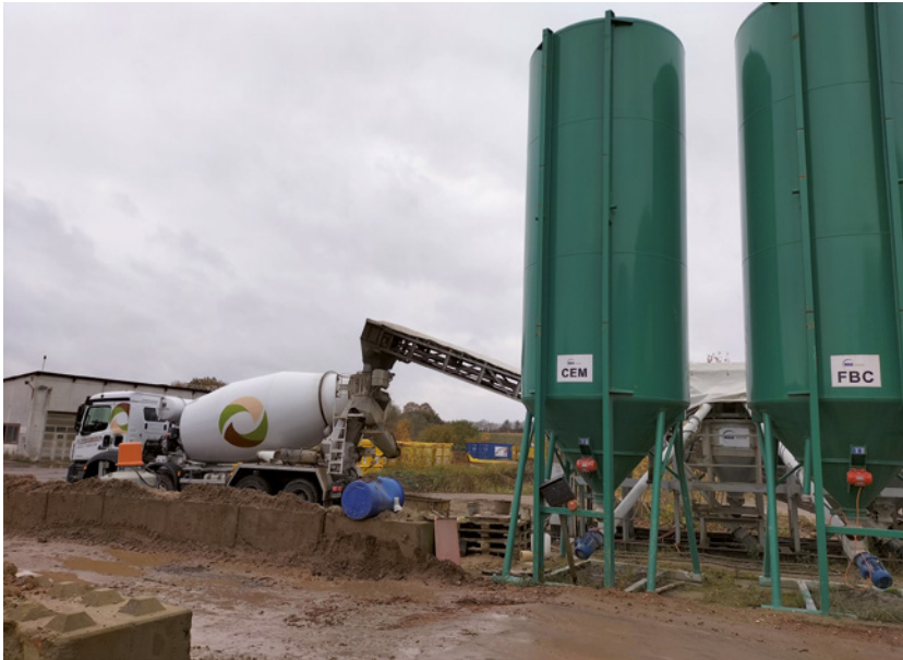
Semimobile Kompaktanlage auf dem Gelände in Grevenkrug. Hier wird der Trommelmischer gerade wieder mit Flüssigboden-Zutaten gefüttert. Die grünen Silos für Zement und Compound haben ein Fassungsvermögen von jeweils 33 cm³. | Foto: B_I/Valdix
