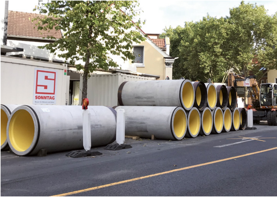
Projekt Datteln (NRW), Baustellenlager Perfect Jacking Pipe DN 1200 von Beton Müller
