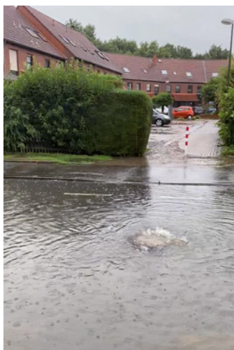
Links: Die Kanalisation war bei den Starkregen im Juli 2021 überfordert.
