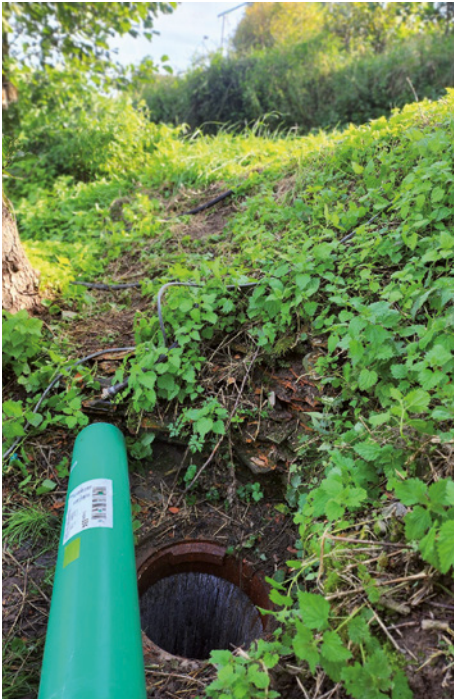
Der Höhenunterschied zwischen dem Startschacht und dem nicht begehbaren Zielschacht beträgt rund 9 Meter. | Foto: Rainer Kiel Kanalsanierung
