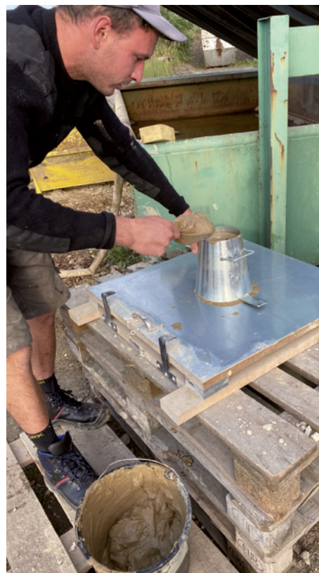
Schachtmeister Pascal Bornstedt bereitet den Ausbreitmaßversuch vor. | Foto: Flüssigboden SH
