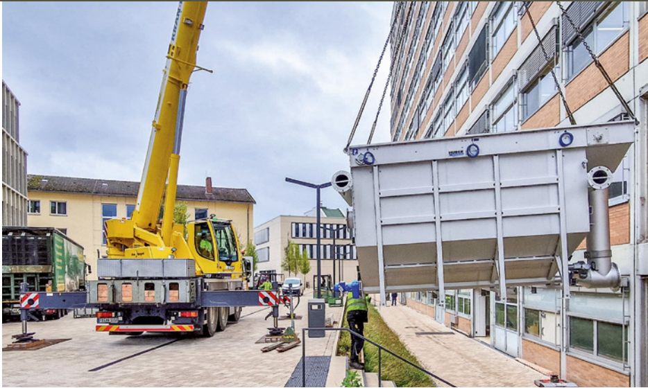
Der Abwasserwärmetauscher wird bei der Anlieferung vom Lkw in das Gebäude der Hochschule gehoben. | Foto: Huber SE
