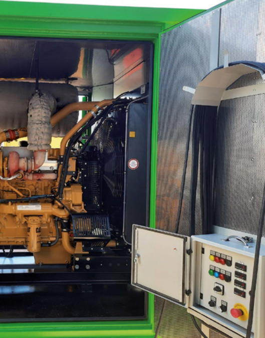
Konstruktive Schallschutzmaßnahmen an HD-Pumpen | Foto: C. Schepelmann, HPS Rental
