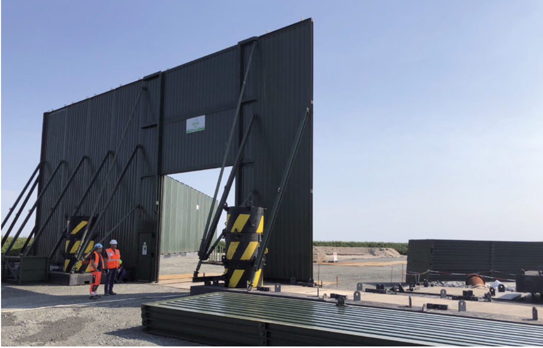
Schallschutzwand | Foto: LMR Drilling
