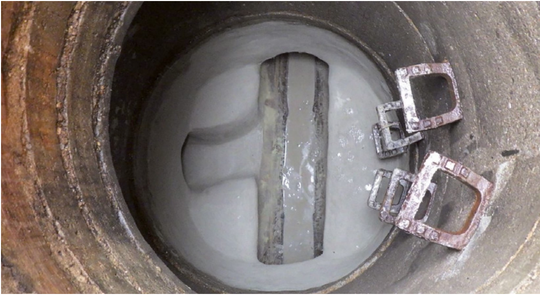
Katec setzte Schachtreparaturen sowie partielle Ausbesserungen mittels Robotertechnik und Schlauchrelining um. | Foto: Katec Kanaltechnik
