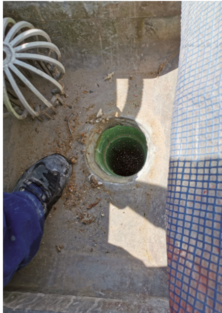
Die Sanierung erfolgte vom Dach aus mit dem Brawoliner HT 3D DN 150-225.
