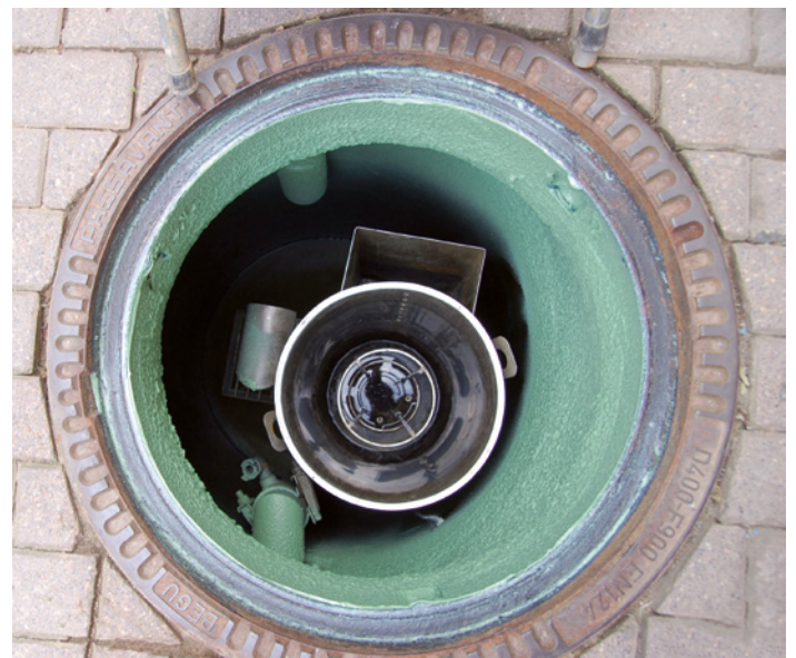
Ölabscheider mit resiShield saniert | Fotos: Resinnovation
