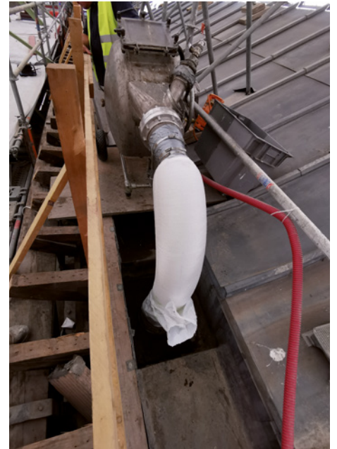
Der Brawoliner HT 3D DN 150-225 wurde mit dem Harz Brawo III imprägniert und am Schluss mit Dampf gehärtet.
