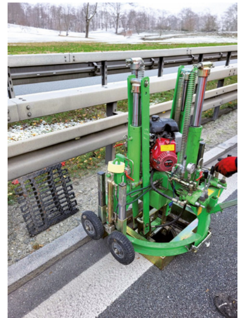
Ein spezieller Schachtrahmenheber hebt den Schachtrahmen aus.
