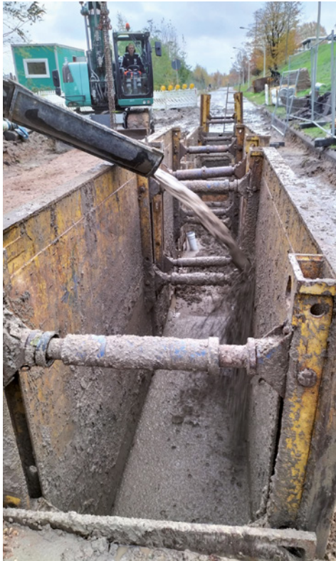
Flüssigboden marsch! Nach der Verlegung der Rohre in 2,05 m bis 3,45 m Tiefe wurden die Rohrgräben verfüllt. | Foto: B_I/Valdix
