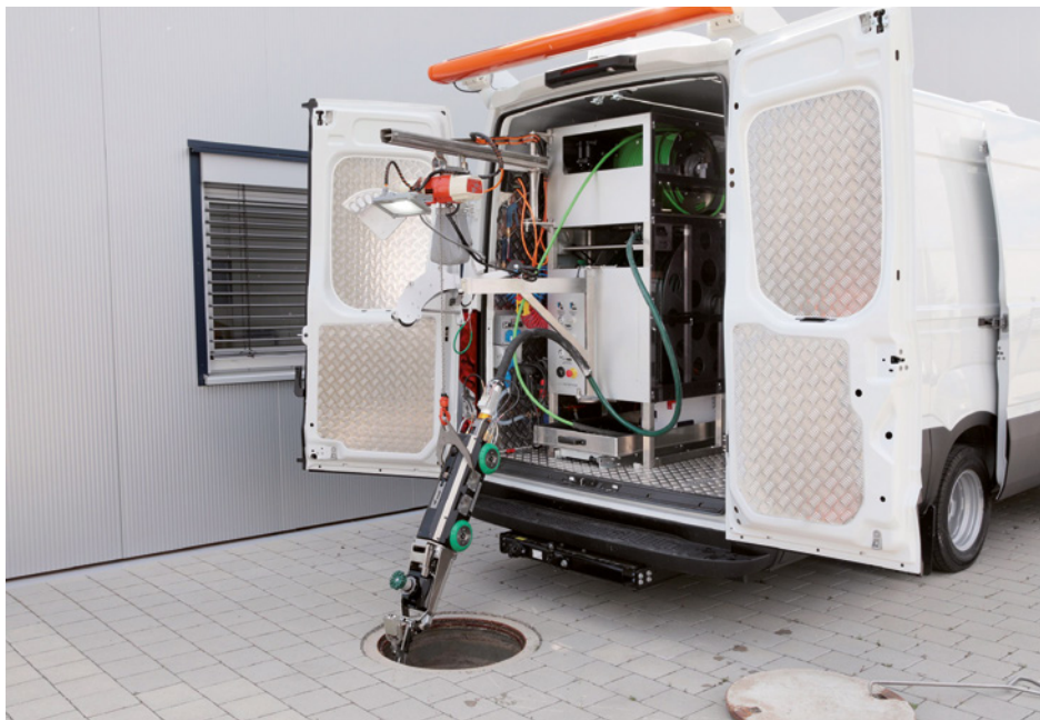
Weniger Lärmbelastung und Abgase durch den Generator und das Hydraulikaggregat im Versorgungsfahrzeug durch Kleinstantriebe | Foto: Pipetronics
