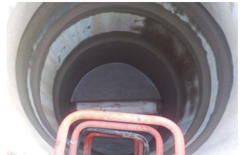
Der Startschacht nach der fachgerechten Sanierung | Foto: SELH
