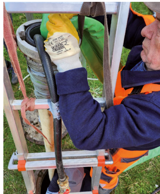
Über eine Inversionsvorrichtung wird der Schlauchliner in die Haltung eingeführt. | Foto: Rainer Kiel Kanalsanierung
