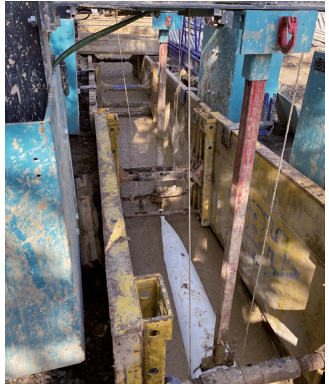
Der Mittelstempel der Auftriebssicherung hält das Rohr per Druckbeaufschlagung unten. | Foto: Flüssigboden SH
