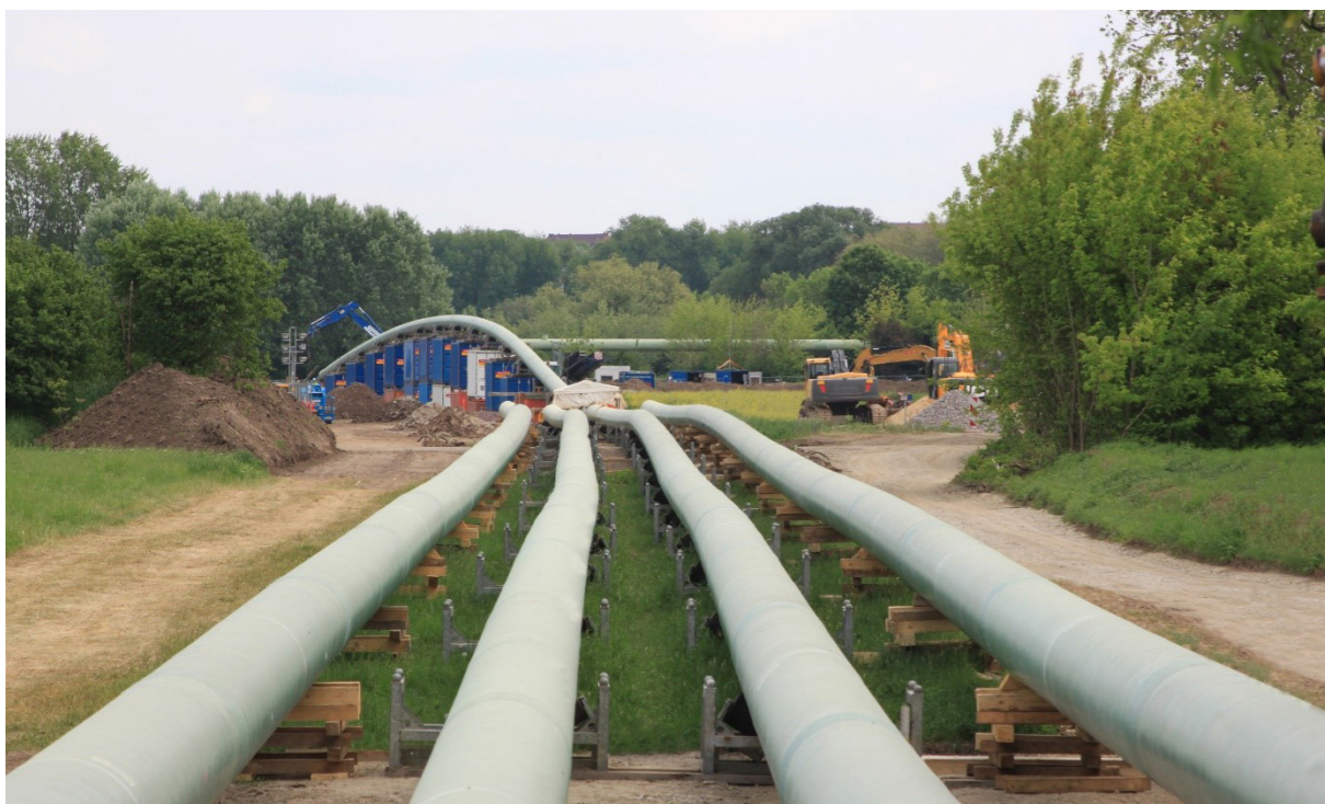
Abbildung 8: werkseitig GFK-beschichtete Rohre - DN 700 - bereit für den Einzug
