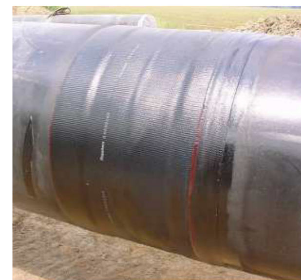
Abbildung 12: Schweißnahtnachumhüllung „DIRAX-System“
