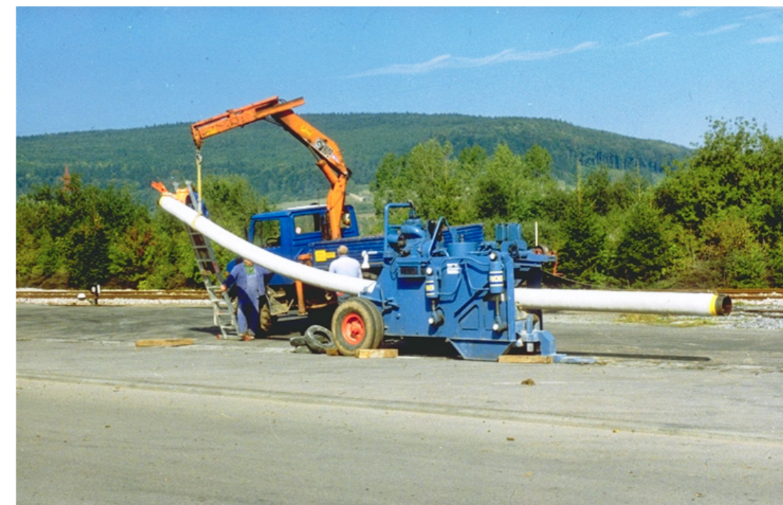
Abbildung 6: Biegen von FZM-ummantelten Rohren
