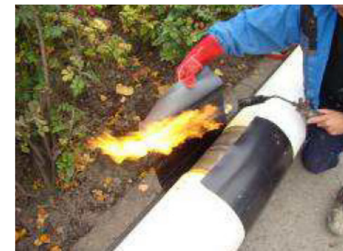
Abbildung 13: Aufbau „DIRAX-System“
