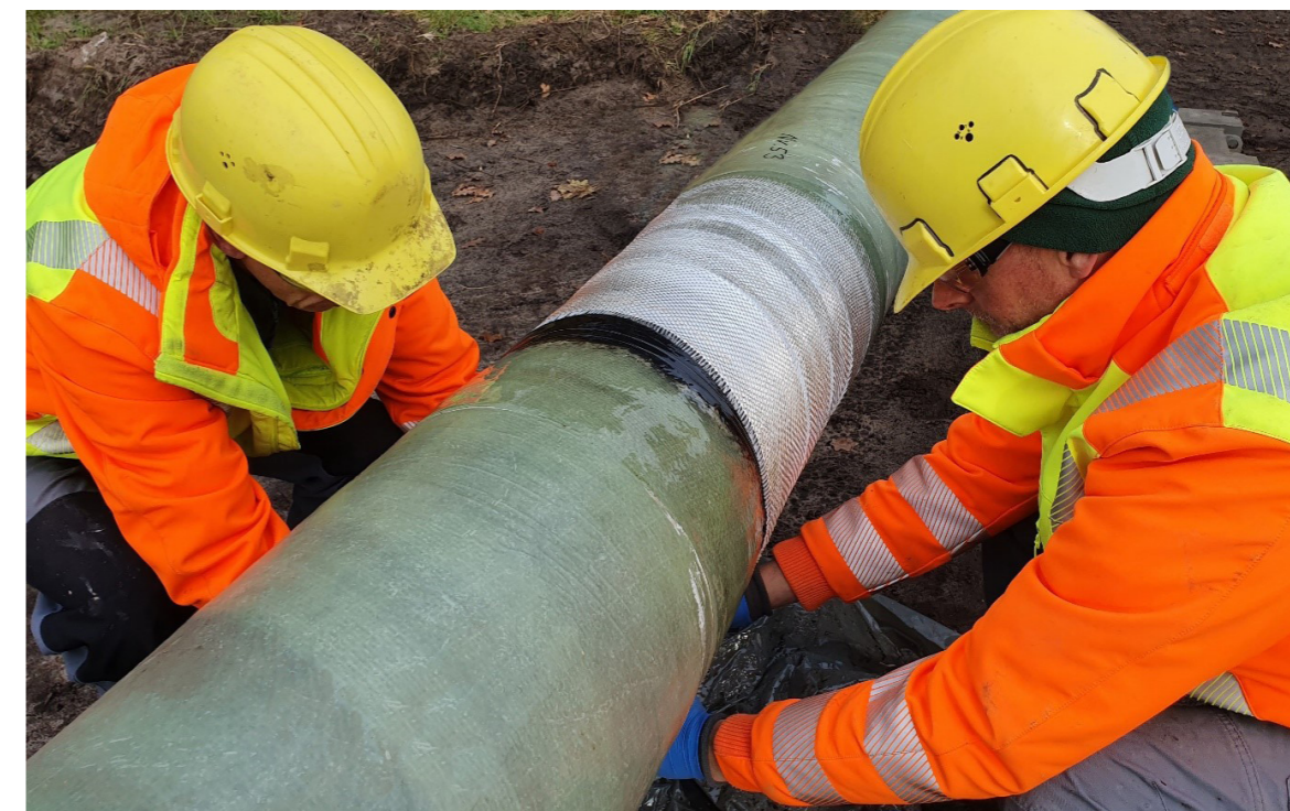
Abbildung 11: Zusätzliche Beschichtung der Schweißnaht mit glasfaserverstärktem Kunststoff
