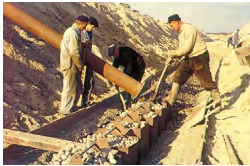
Abb. 2: Bau eines horizontalen Ablaufs (mit Kiespackung) in einem Graben in den 1950er Jahren
