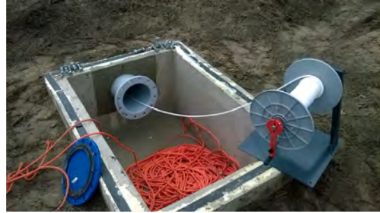
Abb. 11: HDDW direkt nach der Anbringung
