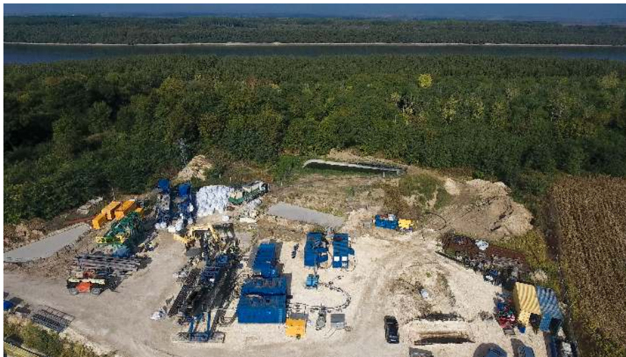
Bild 02: Bohrplatz HDD 1 Blick von Osten nach Westen
