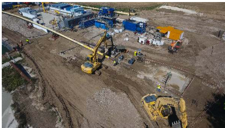
Bild 05: Austrittspunkt Rohreinzug HDD 1
