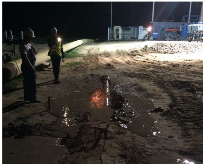
Austritt Pilotbohrung 1 Punch Out Pilot HDD 1
