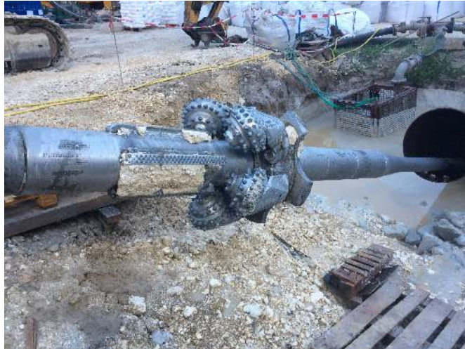
Bild 04: Hole-Opener nach Aufweiten HDD 1
