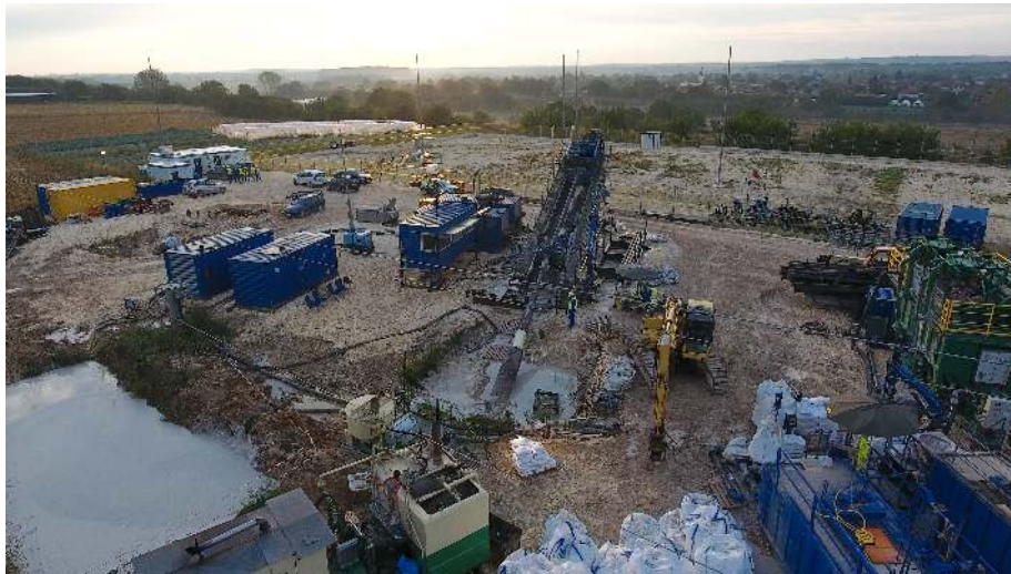
Bild 03: Bohrplatz HDD 1 Blick von Westen nach Osten
