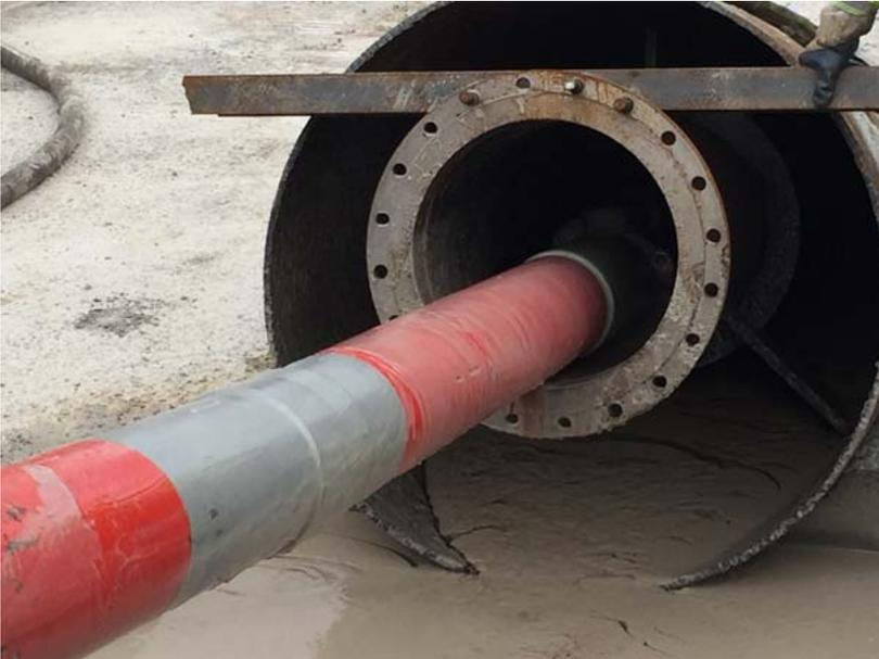
Foto3: Schutzrohr DN 1200 mit DN 500
