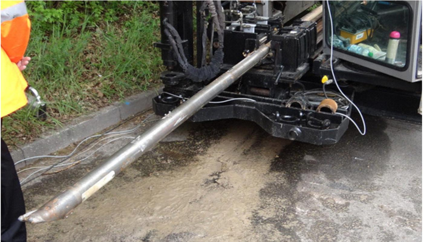
2: HDD-Bohrkopf mit ORFEUS-Radarantennen (hinter dem weißen Kunststoff-Fenster)
