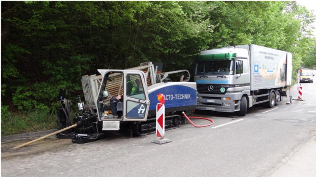
8: Die komplette HDD-Bohreinheit mit Versorgungsfahrzeug
