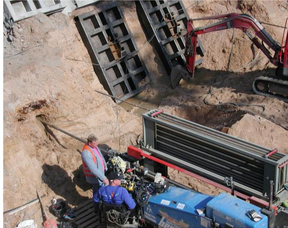
3: Einbau von großen Ankerplatten zur temporären Sicherung eines Bahndammes in Frankfurt/Main
