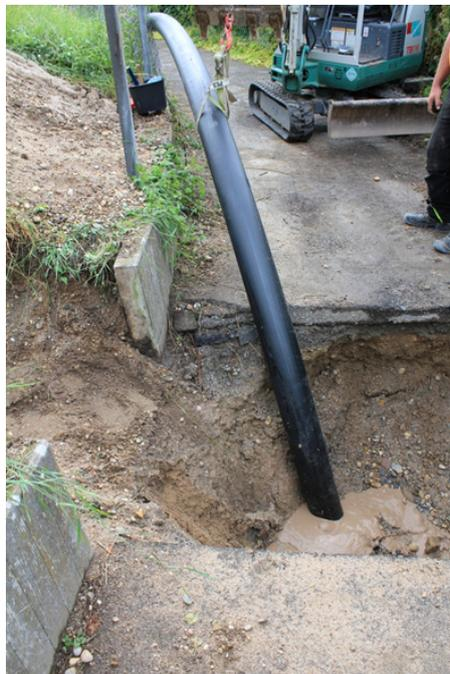
Abb. 12: Rohreinzug in der Zielgrube. Aufgrund des steilen Gefälles muss die Leitung mit einem Oberbogen eingezogen werden
