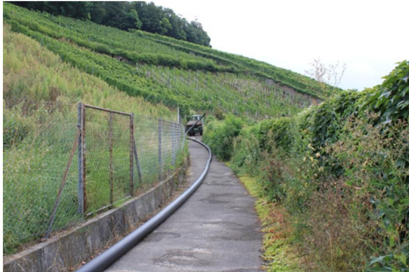
Abb. 11: Die für den Rohreinzug auf einem Querweg ausgelegte Leitung
