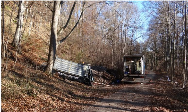
*11: HDD-Bohranlage samt Versorgungs-LKW bei der Bohrlocherstellung für die künftige Hangdränage am Auchtert-Hang (6.12.2016)*
