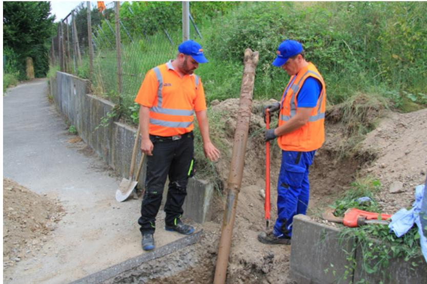
Abb. 8: Ankunft des Rockmaster-Bohrkopfes am gewünschten Zielpunkt an einem oberen Weinbergweg. Man beachte den sehr steilen Austrittswinkel des Bohrkopfes samt Gestänge
