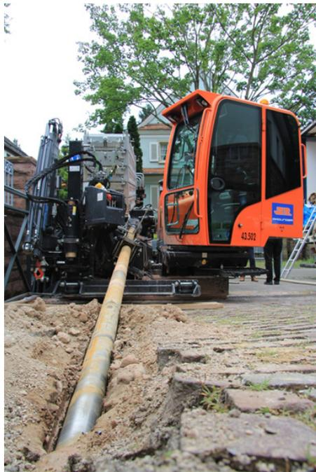
Abb.7: Startpunkt der Pilotbohrung mit Felsbohrkopf (Rollenmeißel) mit Elicon - Doppelbohrgestänge
