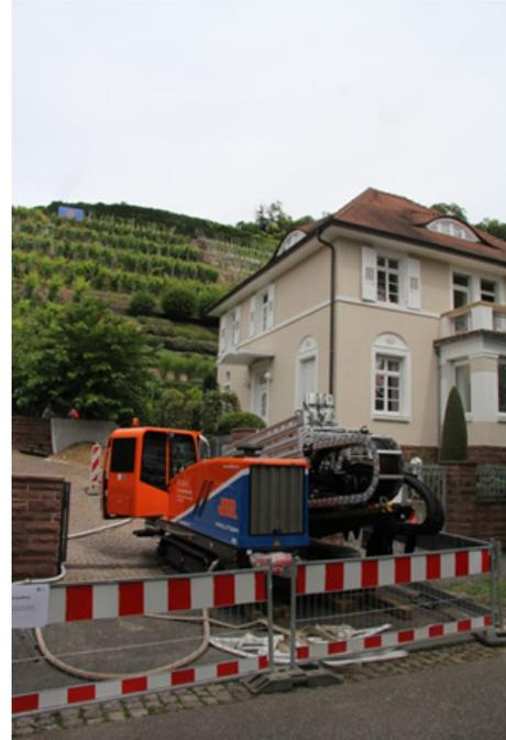
Abb. 4 und 5: Die HDD-Bohranlage vom Typ Grundodrill 18 ACS wurde aufgrund der sehr beengten Platzverhältnisse am Rande einer Hofzufahrt installiert
