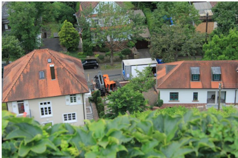
Abb. 9: Blick vom Weinberghang auf die HDD-Anlage zwischen den Gebäuden. Daneben ist der Versorgungs-Lkw mit den integrierten Bohrspülmisch tanks sichtbar
