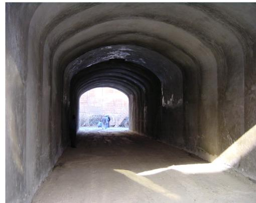
6-9: Bauausführung der Fußgängertunnel mit HDD-Firstsicherungsbohrungen
