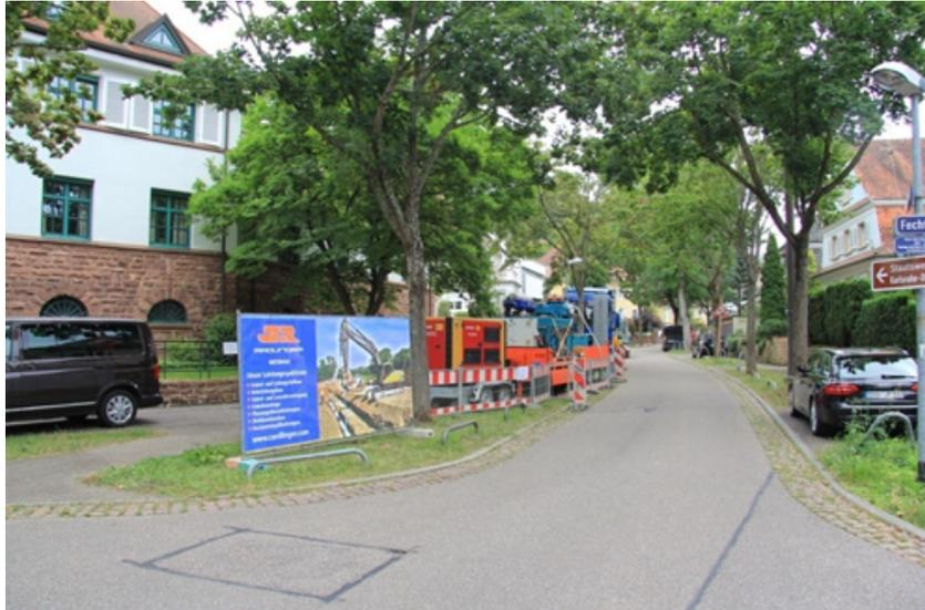
Abb. 6: Alle Zufahrtswege am Villenhang mussten freigehalten werden. Die HDD-Begleitgeräte (z.B. die Recyclinganlage) wurden auf einem Grünstreifen angeordnet
